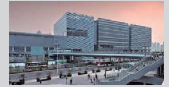
無錫中央駅 TOD 開発 Wuxi Center Station TOD 中国江蘇省 Jiangsu, China 2011
